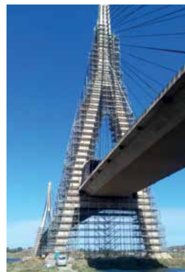
\ Puente sobre el río Guadiana, Portugal \ Bridge over Guadiana river, Portugal
