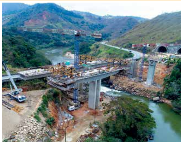
\ Desdoblamiento vía BR-381, Brasil
